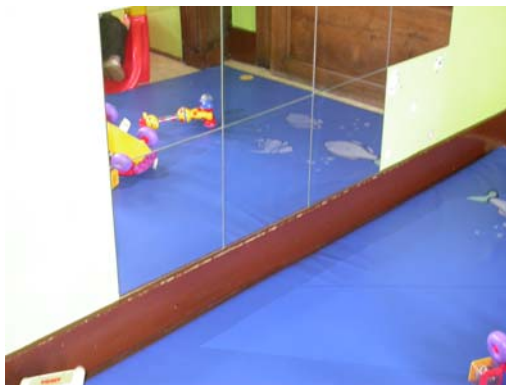
Houten plinten beschilderd met loodhoudende verf in een speelruimte
