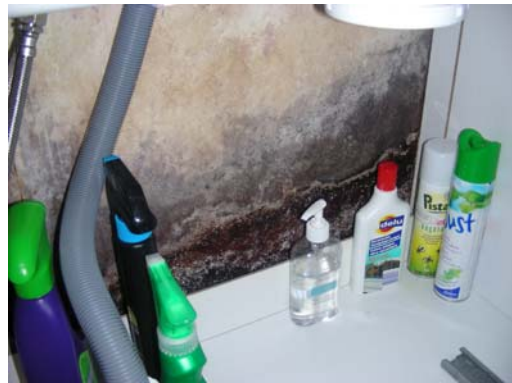
Schimmels achter een geïnstalleerde keuken
