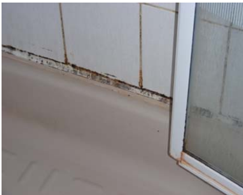
Schimmels in de voegen/scharnieren van een douchecabine
