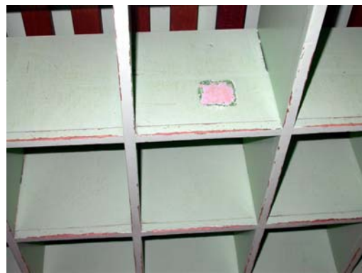
Kleine kinderkastjes die beschilderd zijn met loodhoudende verf die afbladdert
