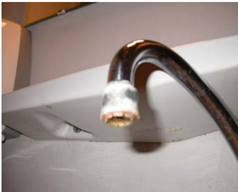
Sproeikop bedekt met kalkaanslag
