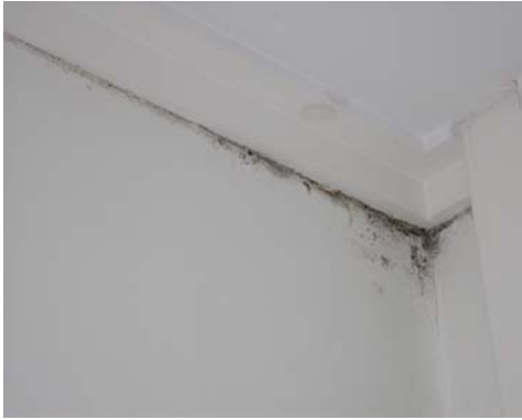
Schimmels in een hoek tussen muur en plafond
